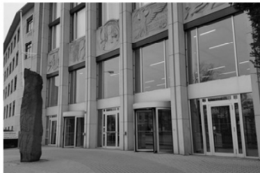
Die Fassade des Essener Landgerichts. © Jörn Hartwich
